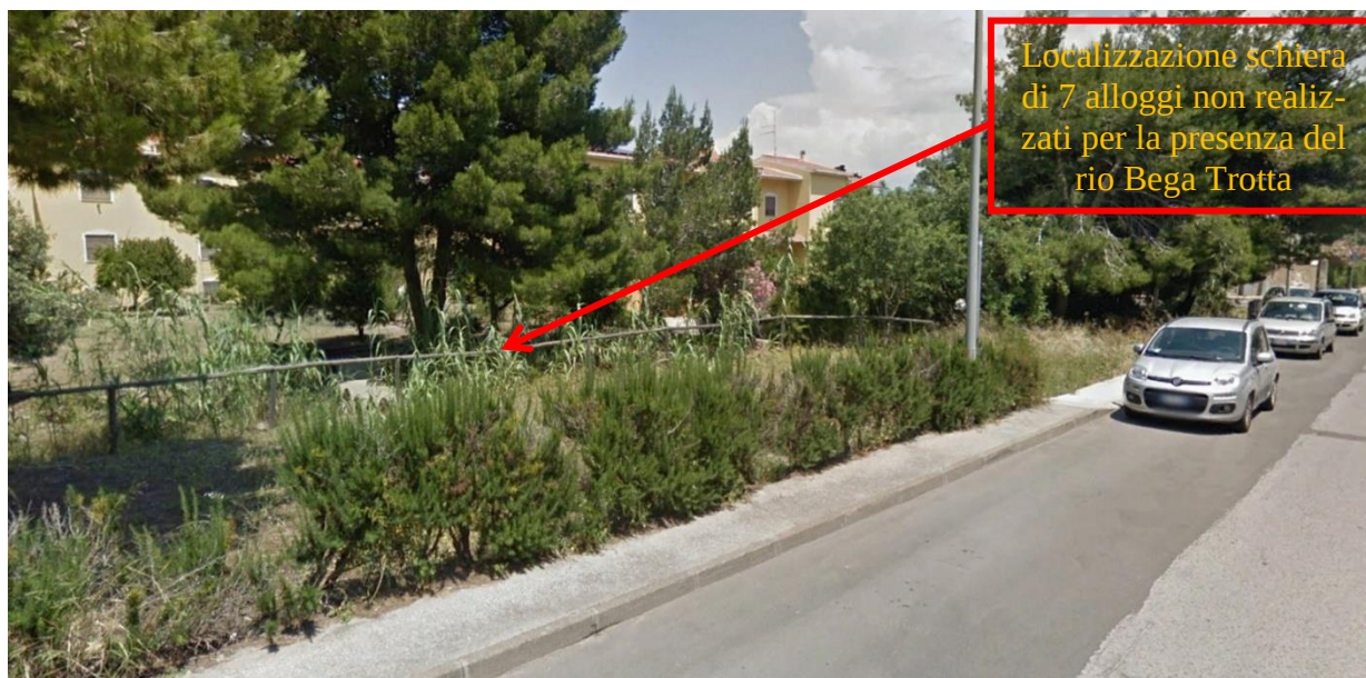
Figura 25 - Vista dalla Via Bologna: area lato F. 13 mappali nn. 228 e 229 (immagine Google Earth)
