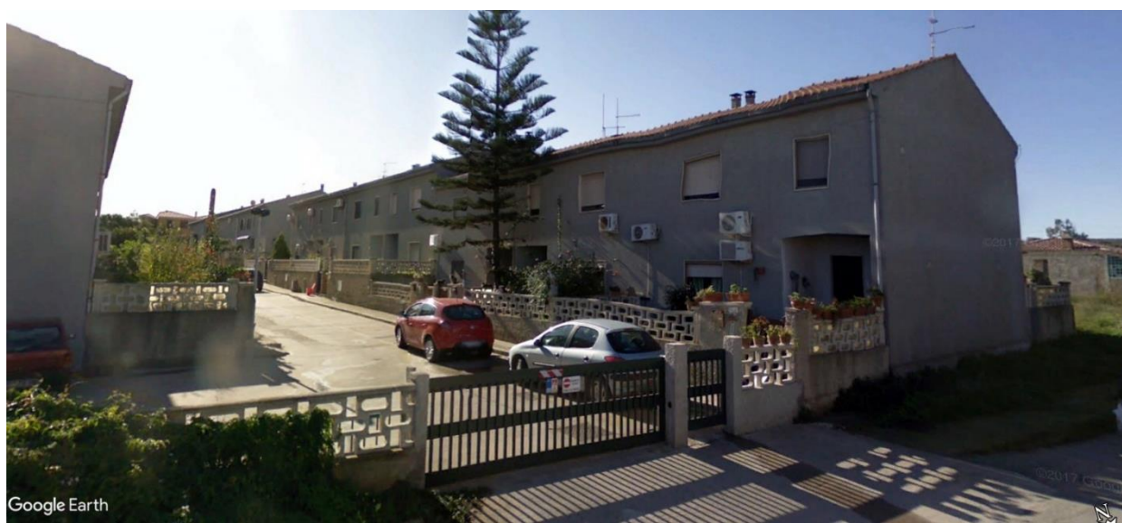
Figura 49 - Vista ingresso al lotto lungo la Via Trilussa (immagine Google Earth)
