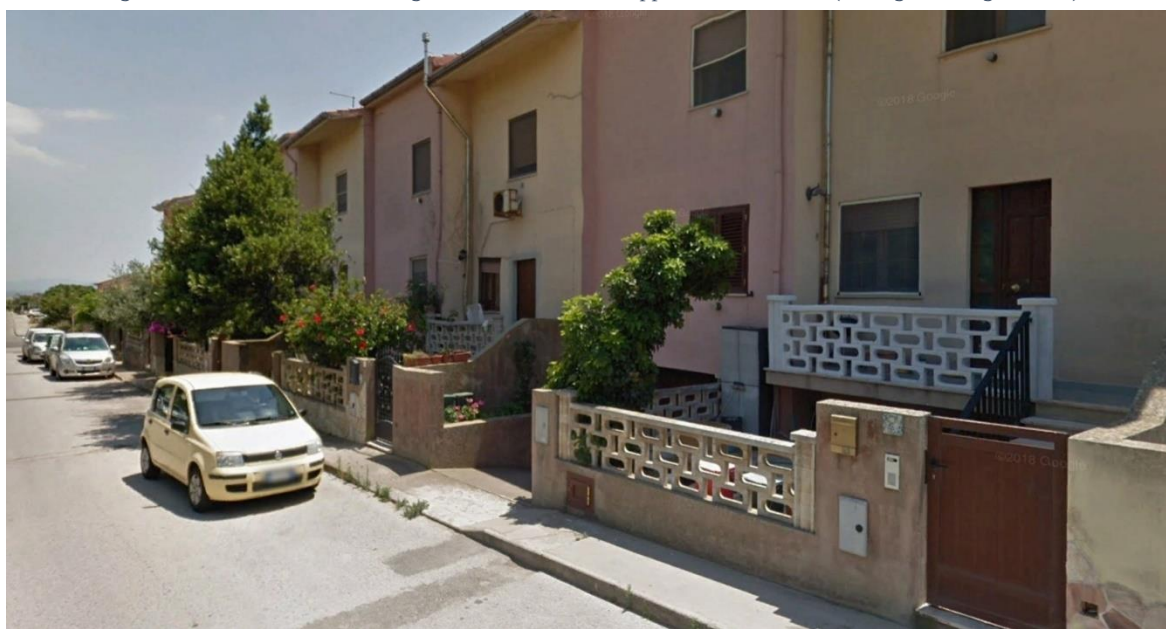
Figura 26 - Foto schiera sulla Via Bologna, lato F. 16 mappale n. 73 (immagine Google Earth)
