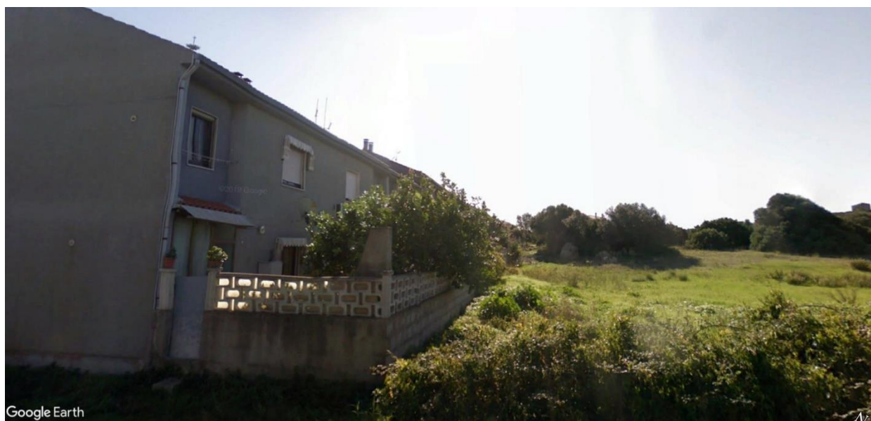
Figura 50 - Vista posteriore al lotto lungo la Via Trilussa (immagine Google Earth)
